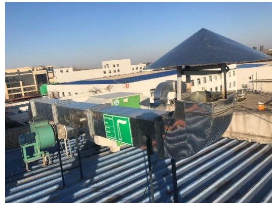
二车间热交换排气筒
